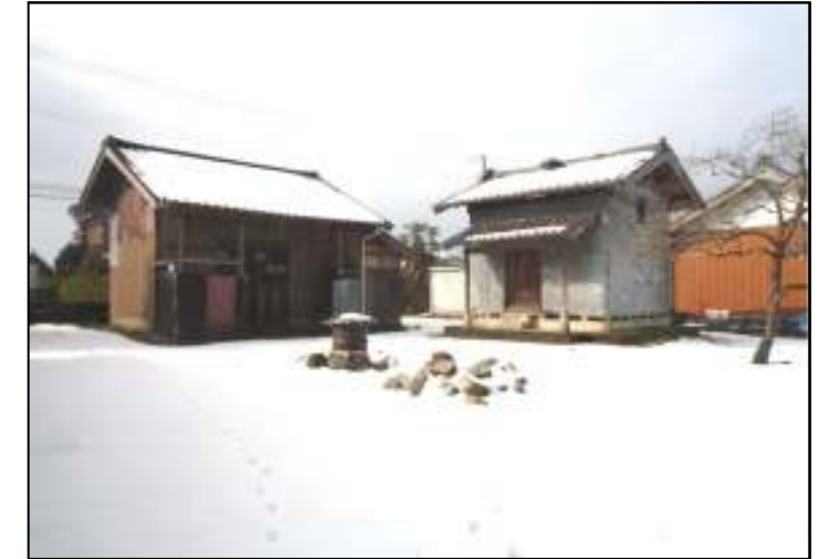
【別棟 作業場・倉庫】
